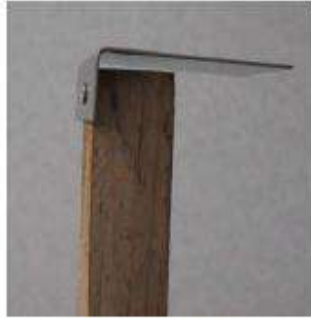
Maintien par vis de fixation
